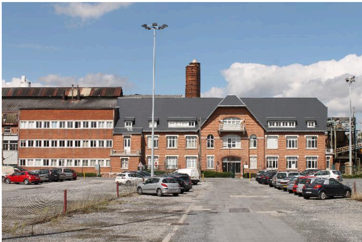
Les bureaux, façade sur rue, vue de face.
