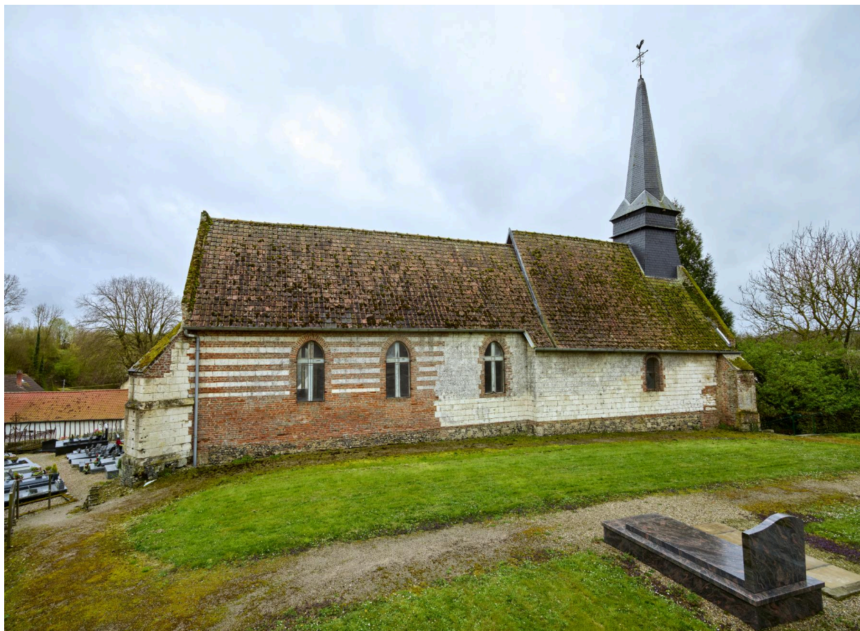
Élévation nord de l'église.
