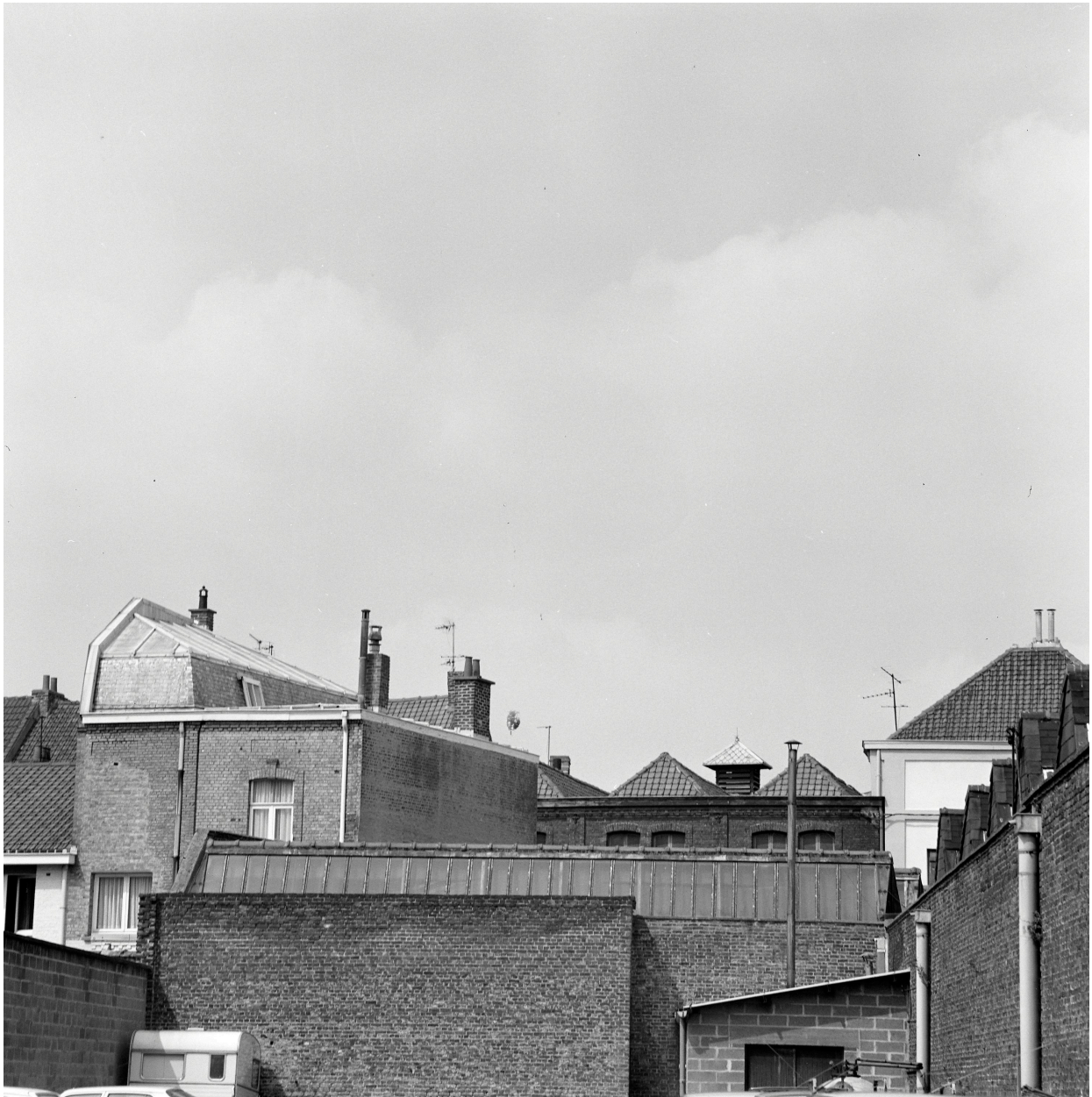
Couvrement de la malterie, vers l'ouest.
