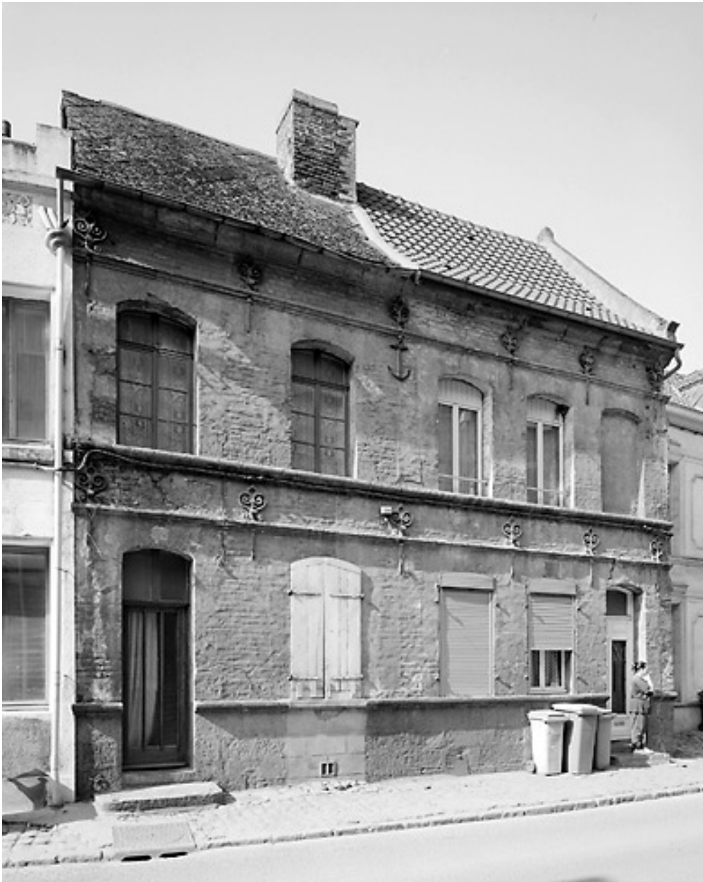
Vue générale de la série (état en 2001).
