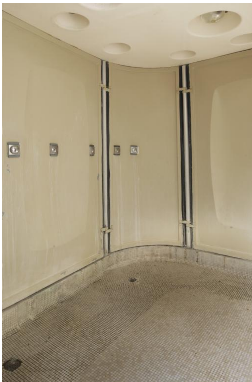
Vue intérieure des douches.
