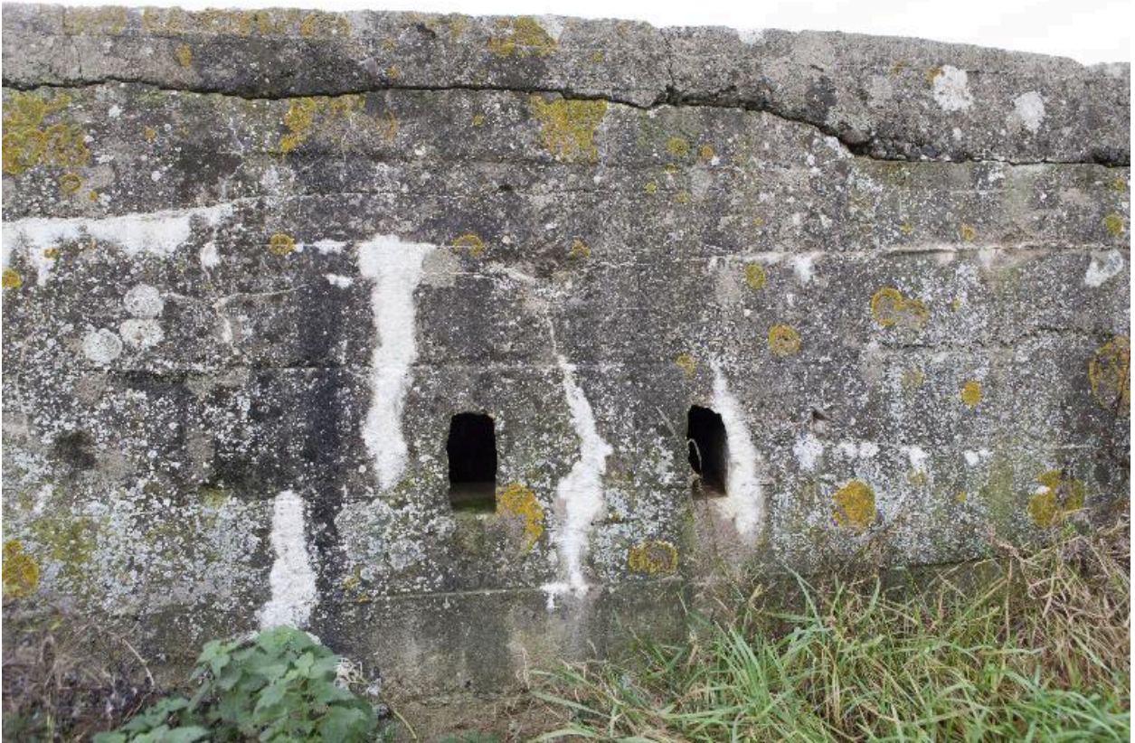
Petites embrasures dans l'élévation postérieure (créneaux de fusillade ?)
