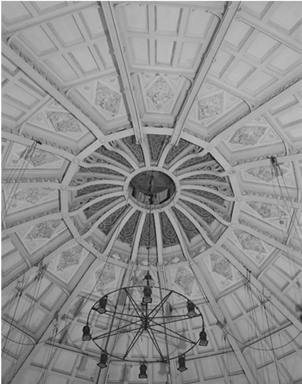
Vue de la partie centrale de la charpente métallique formant verrière.
