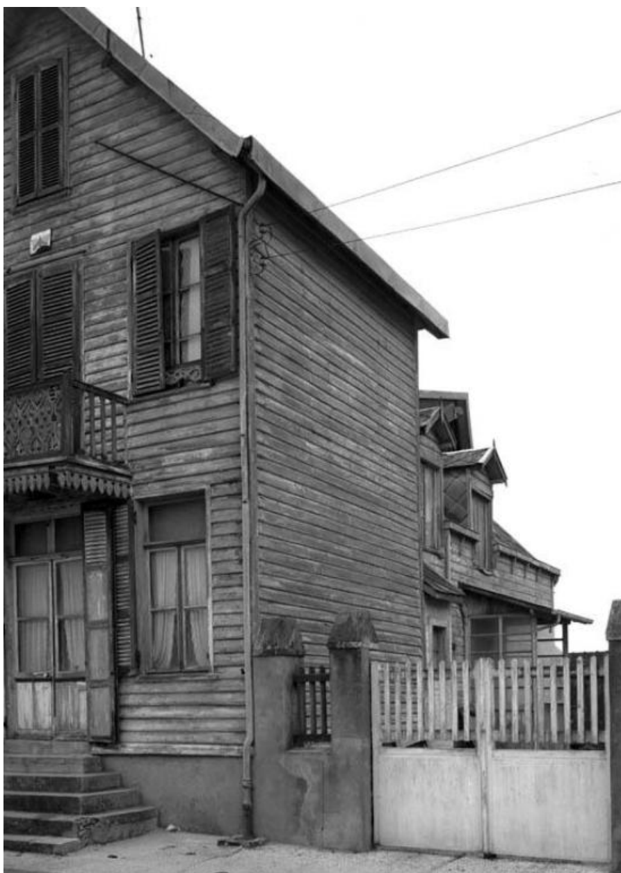
Façade latérale droite.
