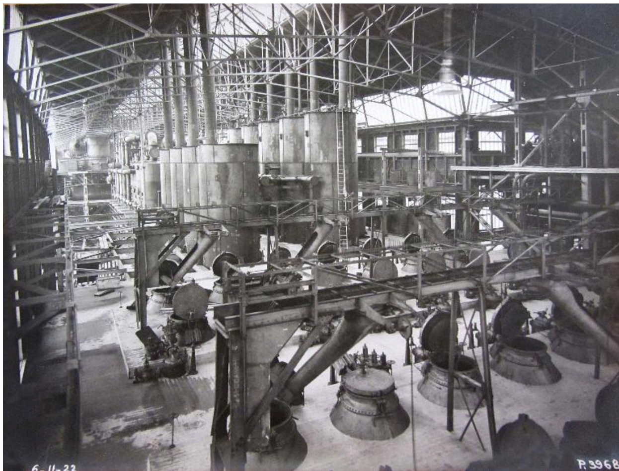
Intérieur de la sucrierie et de la batterie de diffusion, 6 novembre 1922 (AD Somme ; 49 Fi 19).
