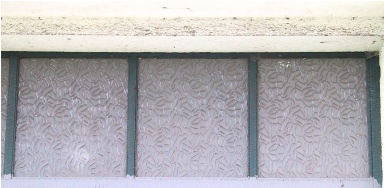
Solarium, détail de la vitrerie d'origine, état en 2005.
