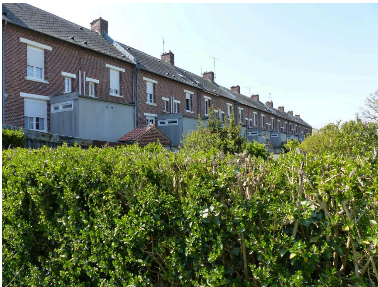
Vue des façades sur jardin.
