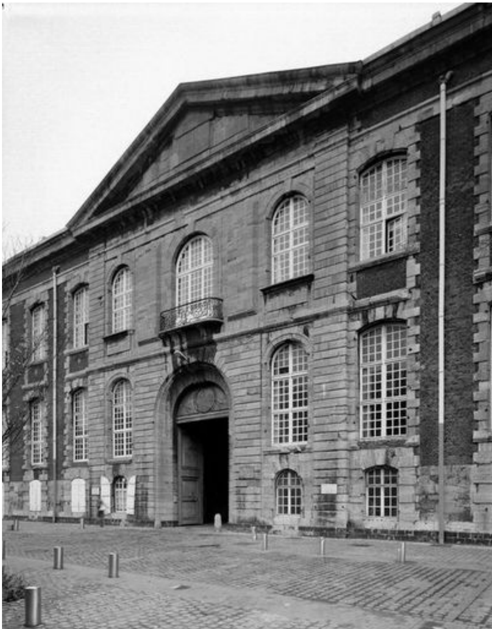
Façade principale donnant sur la place de l'Hôpital-général, détail de l'avant-corps central, vue de trois-quarts droit.
