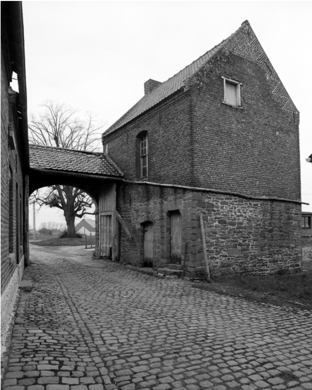
Le bâtiment dit Plaidoyable et le porche depuis la cour.
