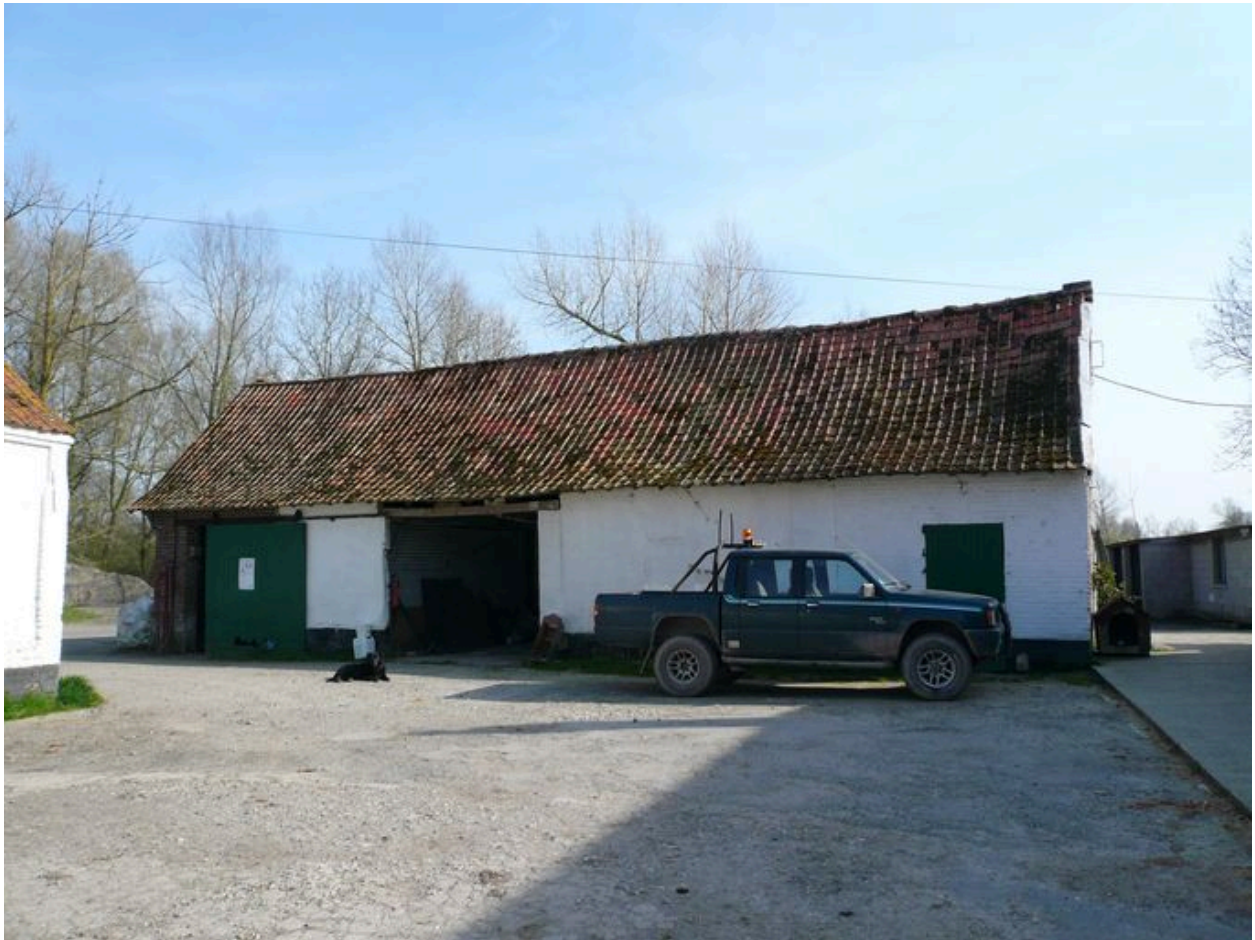
Vue de la grange depuis la cour.
