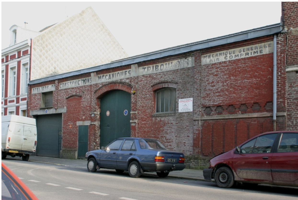
Façade antérieure des ateliers.
