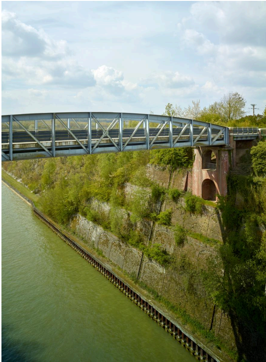
Vue vers le Nord depuis le second pont routier. Murs de soutènements en gradins.
