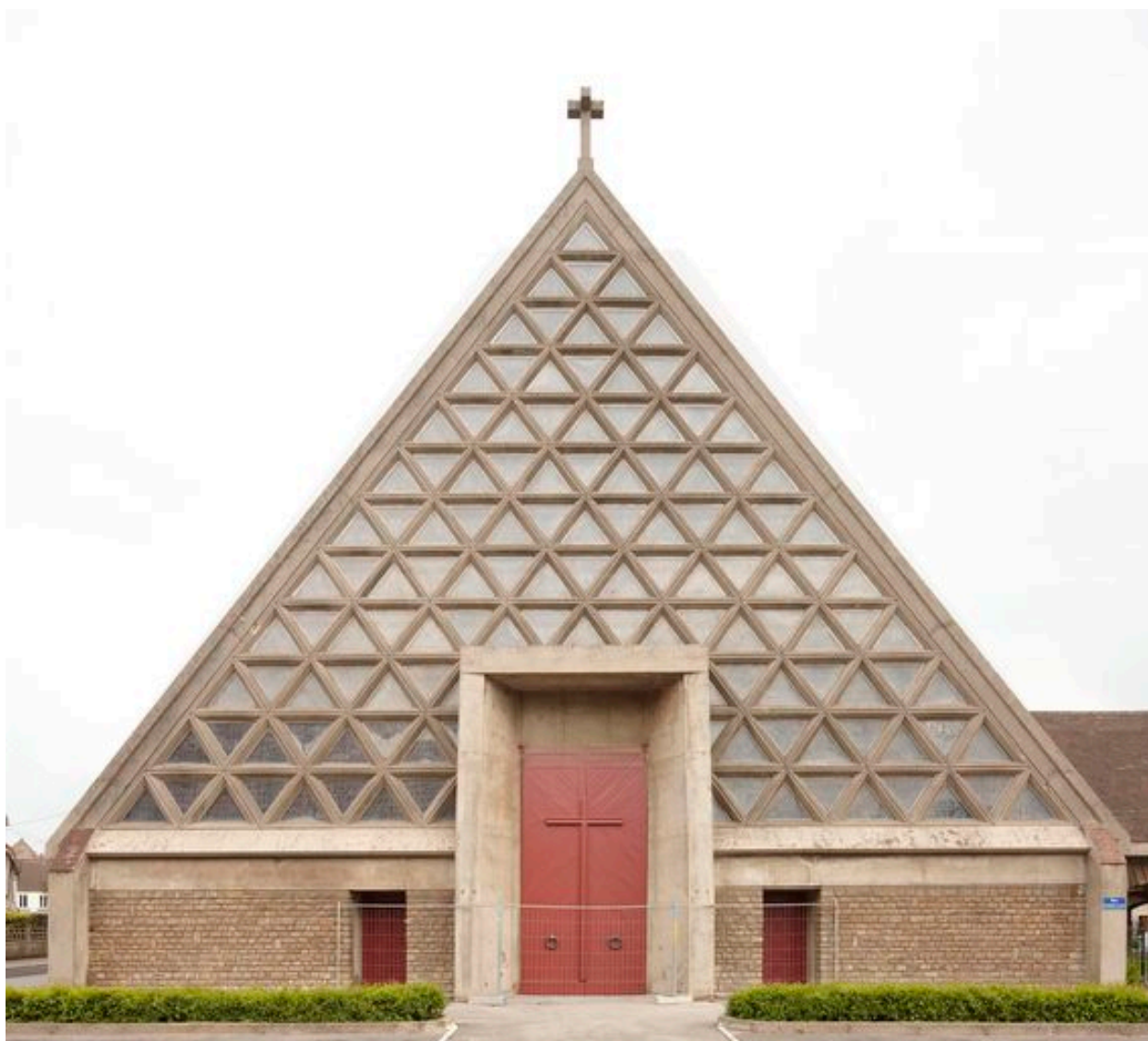
Vue de la façade.
