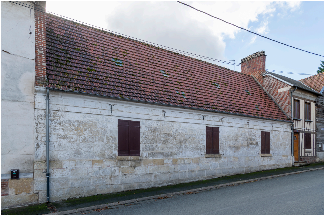
Logis en pierre, n°4 de la rue d'En-Bas, vue depuis le nord.
