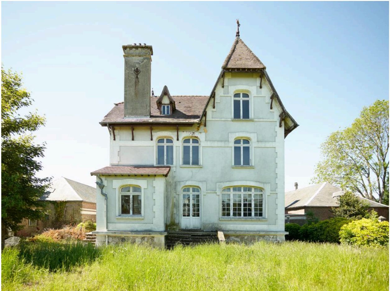
Vue de la façade arrière.
