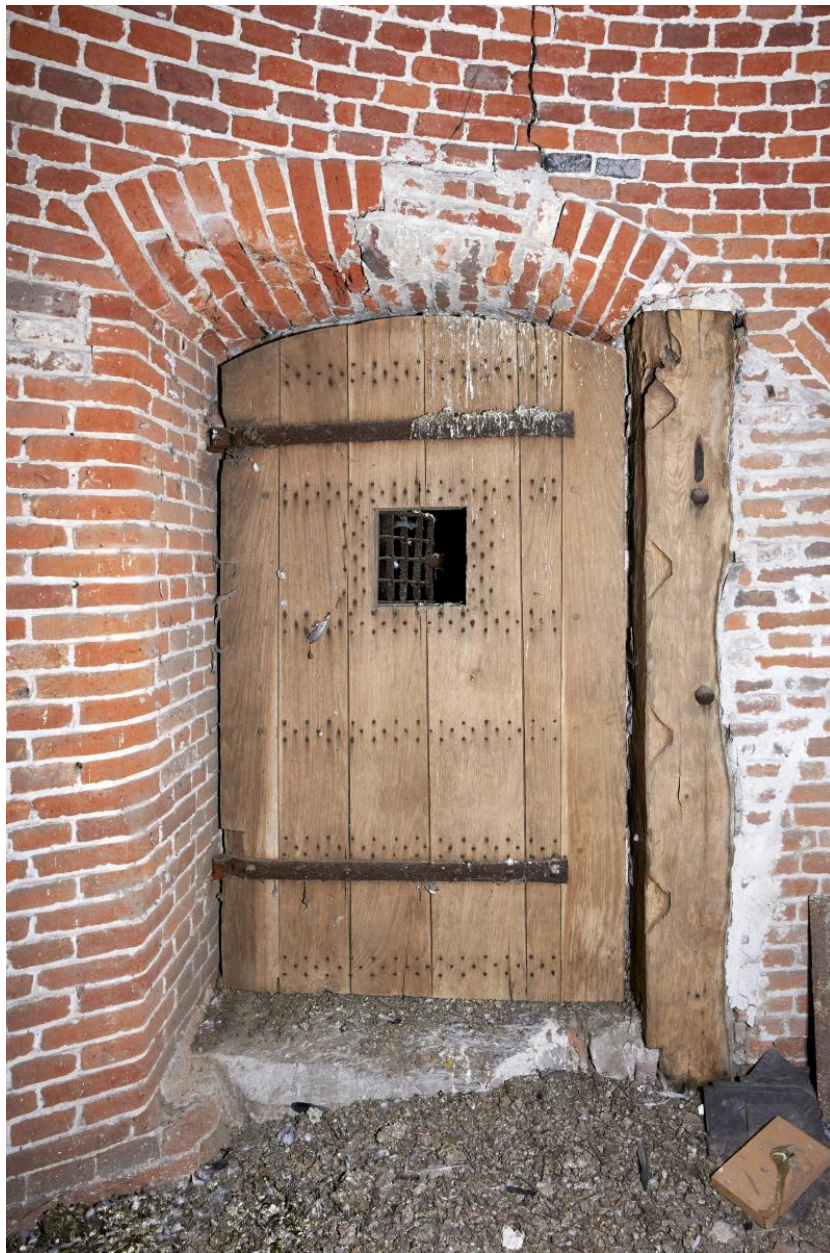
Niveau principal (R+1). Porte d'accès. Vue depuis l'intérieur. Porte à guichet. Poutre en réemploi dans un des piedsroits.
