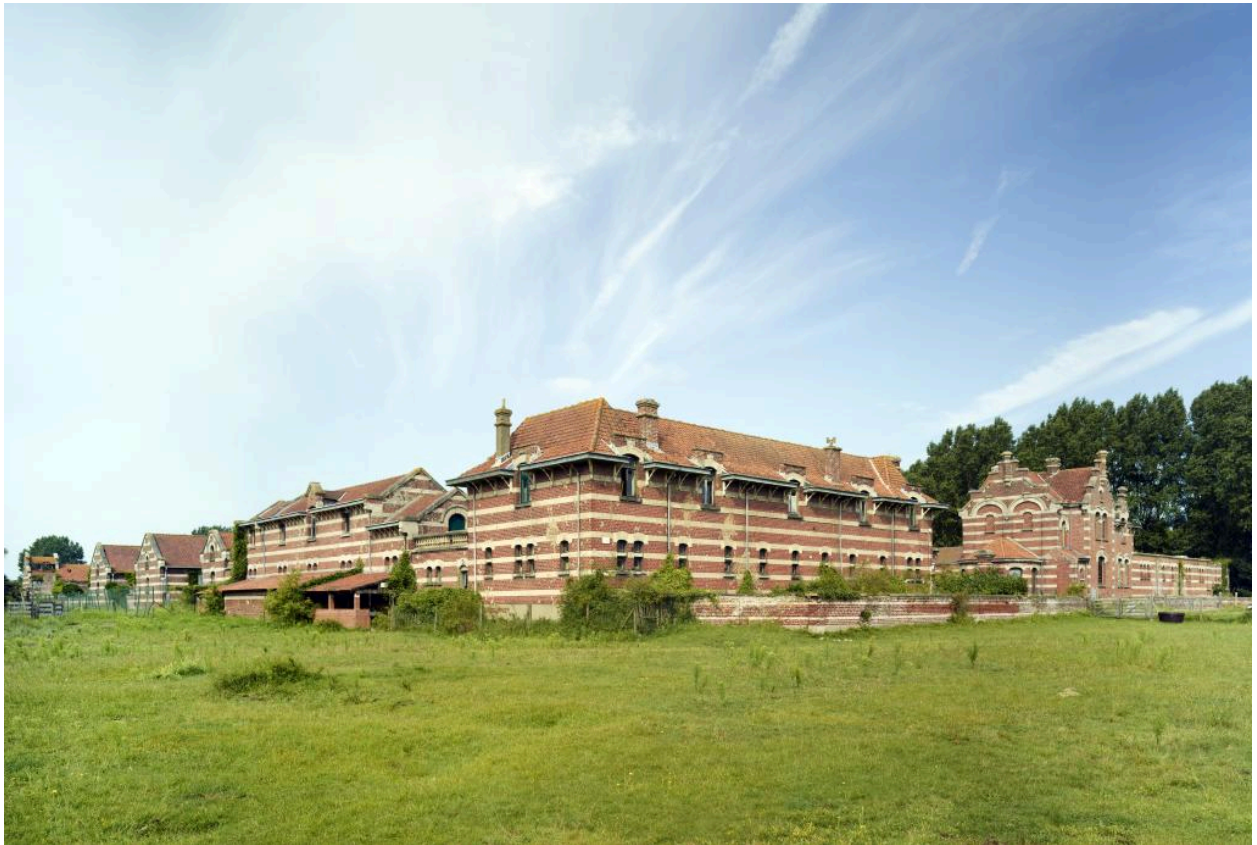
Vue d'ensemble de la ferme depuis le sud-est.
