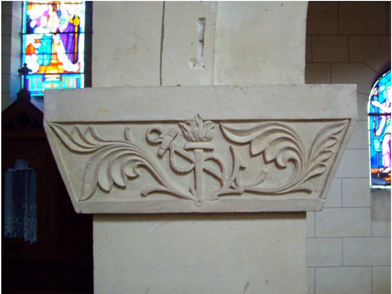
Vue du chapiteau d'un pilier de la nef.
