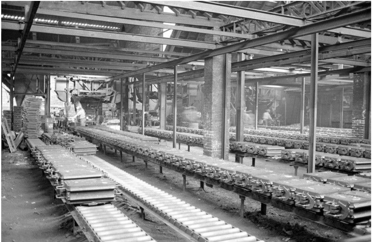
Atelier de fabrication, vue intérieure en 1990.
