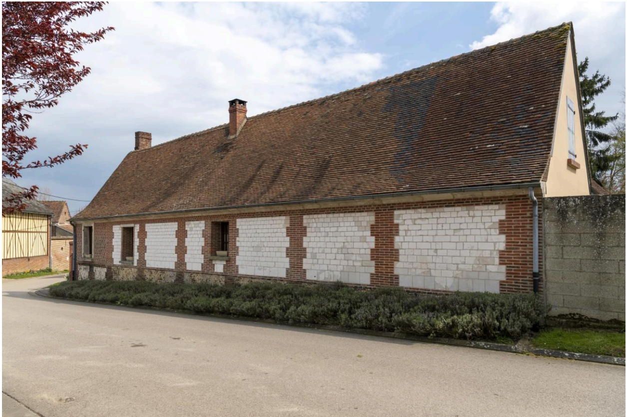
Logis en brique et pierre, n°42 rue de Boursines, vue depuis le nord-ouest.
