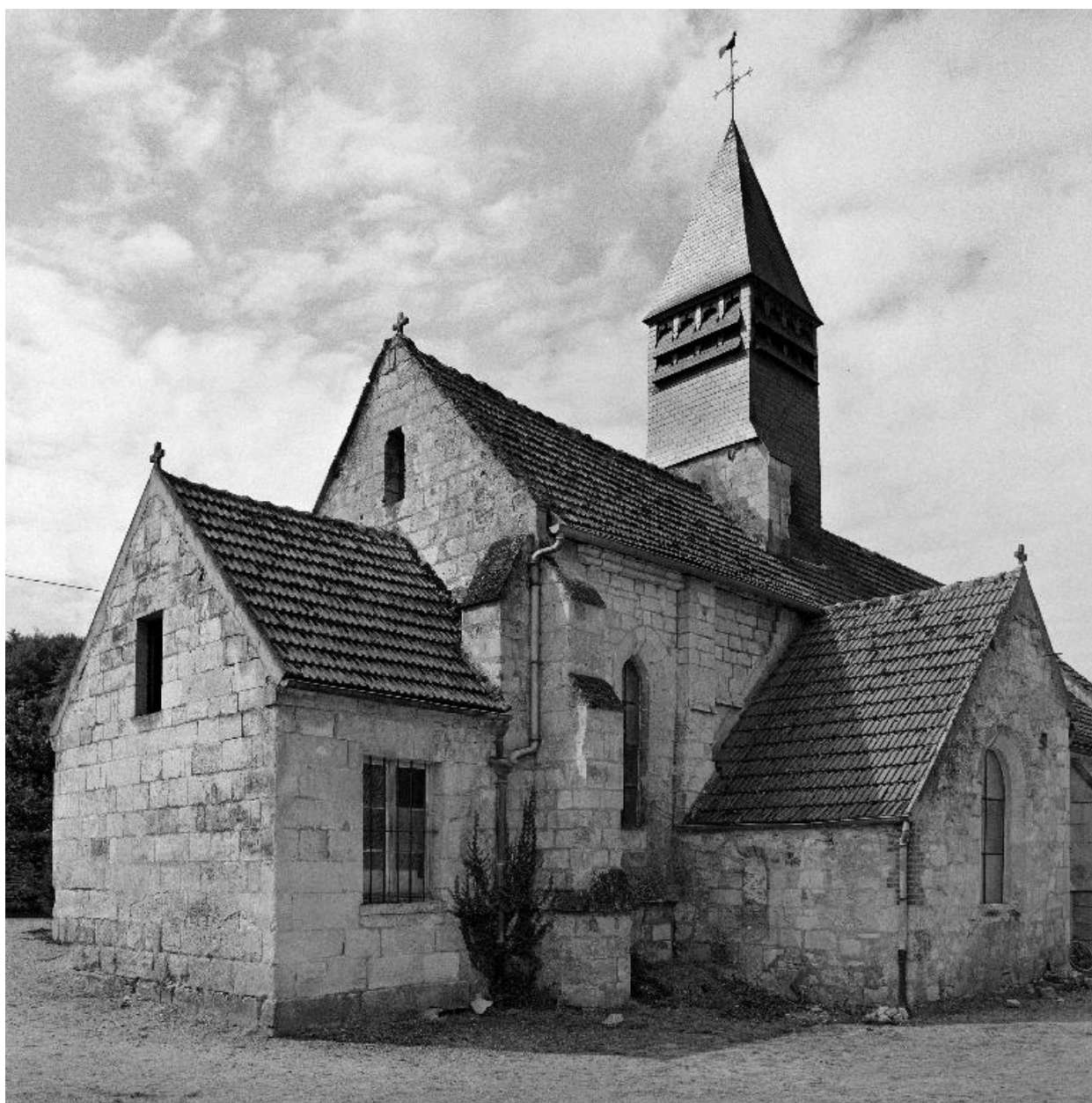
Vue extérieure de la sacristie et du chœur, depuis le nord-est.
