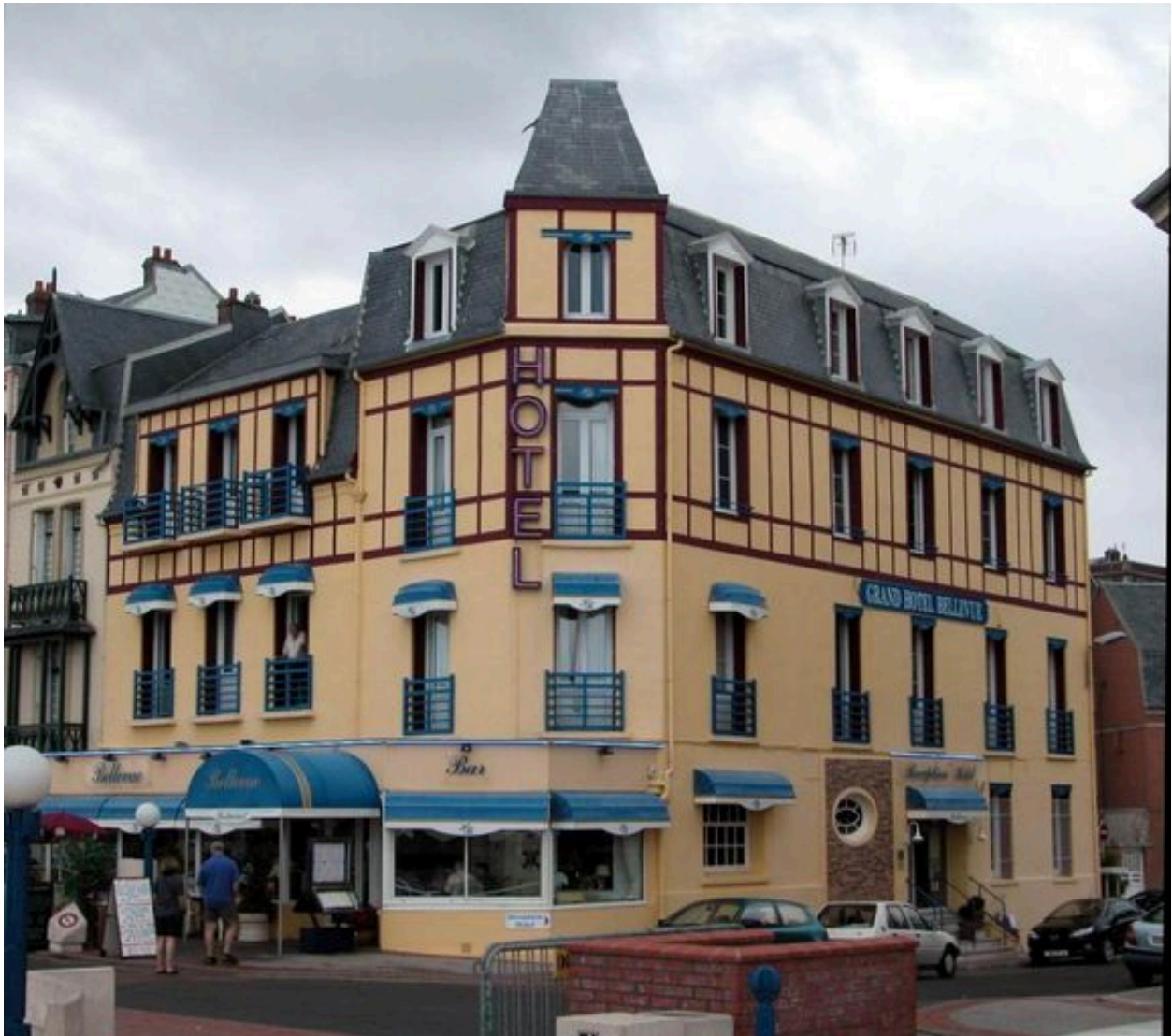
Vue d'ensemble depuis l'esplanade.
