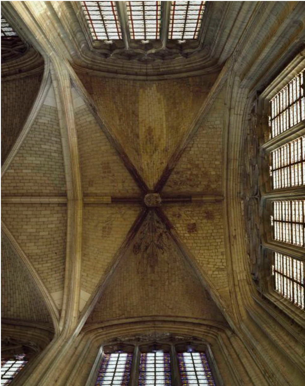
Vue partielle de la voûte du bras sud du second ou petit transept.
