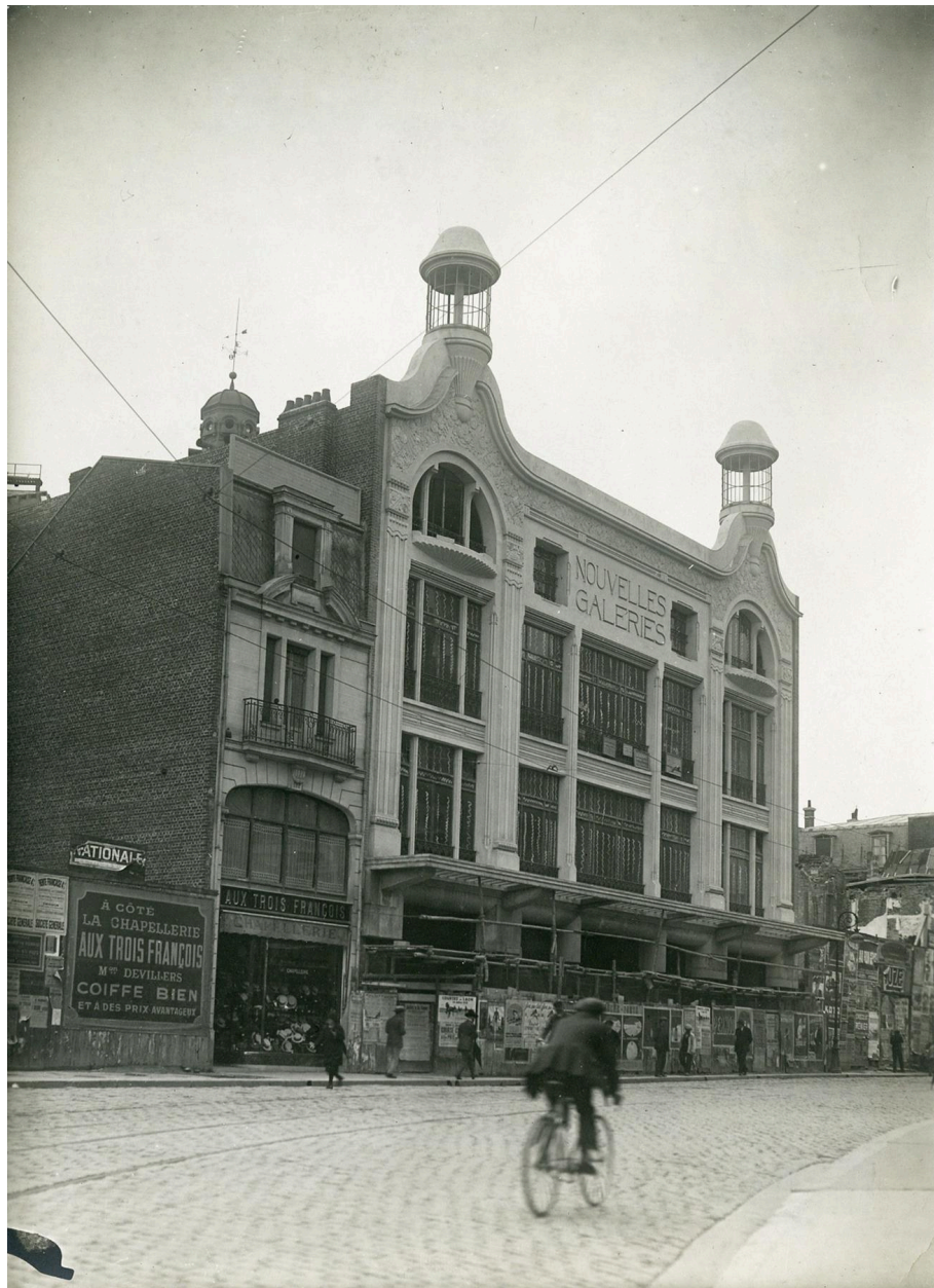
Chantier de construction des Nouvelles Galeries, façade principale, vers 1926 (Cité de l'Architecture et du Patrimoine. Centre d'archives ; 3-D-364).
