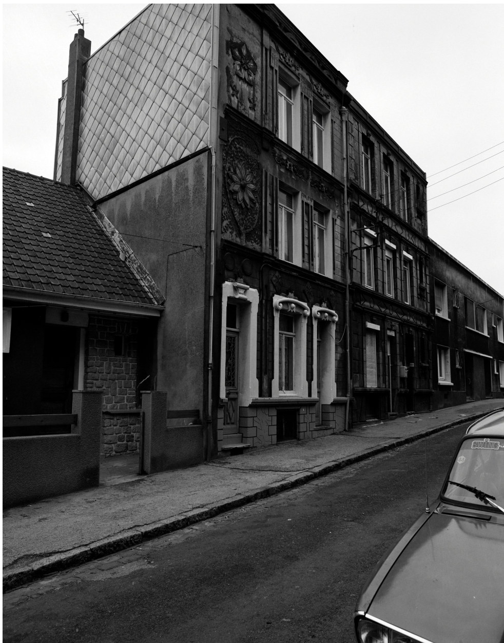
Vue d'angle sur voie.
