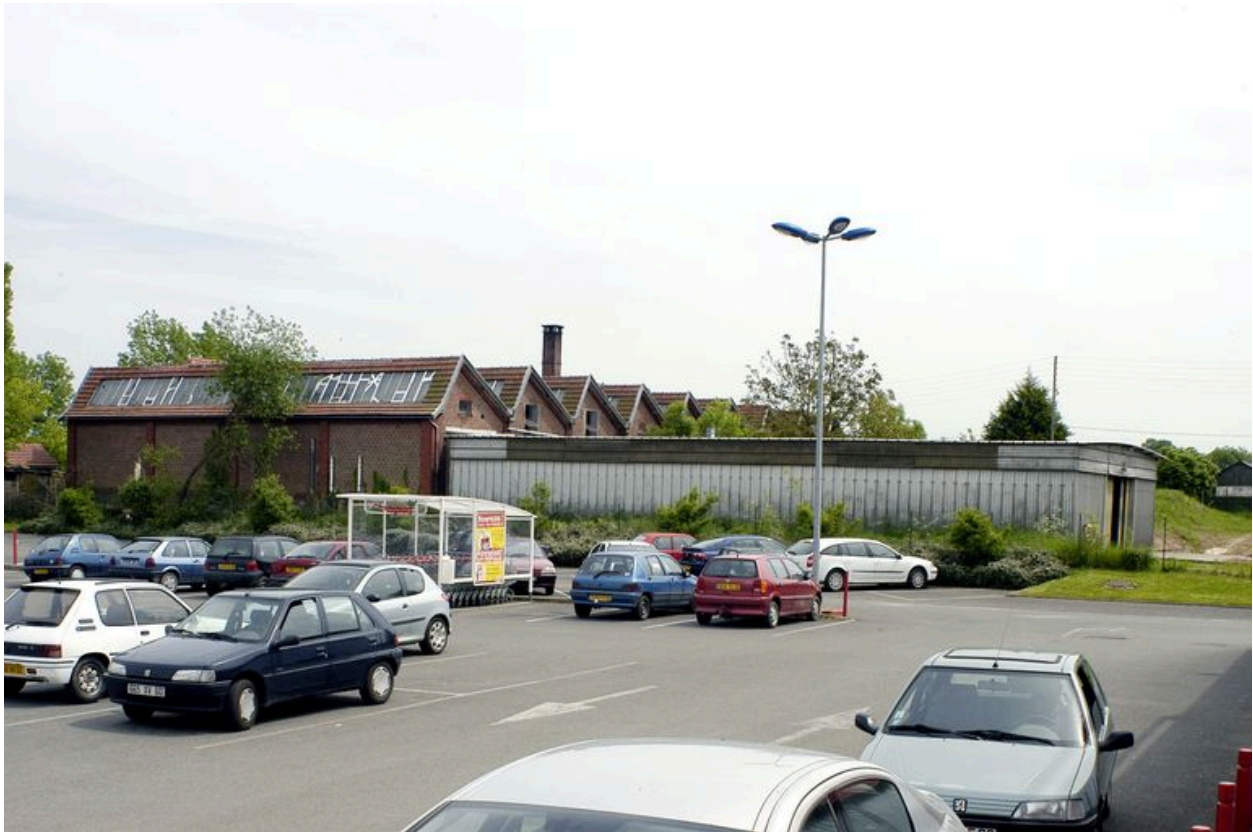
Vue d'ensemble postérieure de l'usine.
