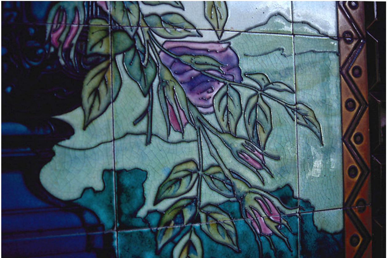
Porche : décor de céramique à droite en entrant, détail de mise en œuvre.
