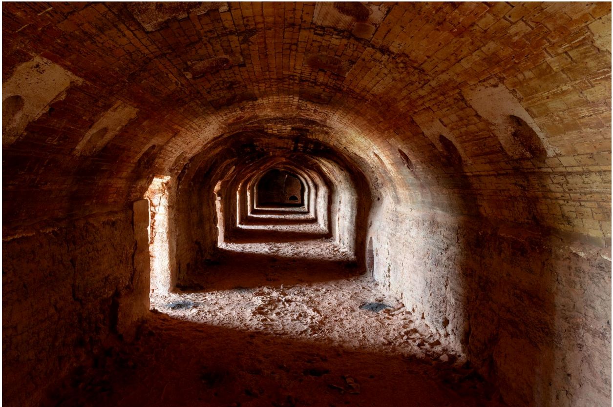
Four Hoffmann. Galerie de cuisson des briques.
