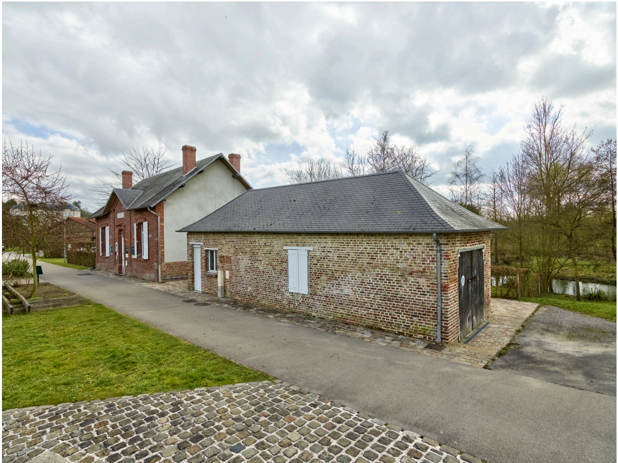
Vue de la maison, depuis l'ouest.
