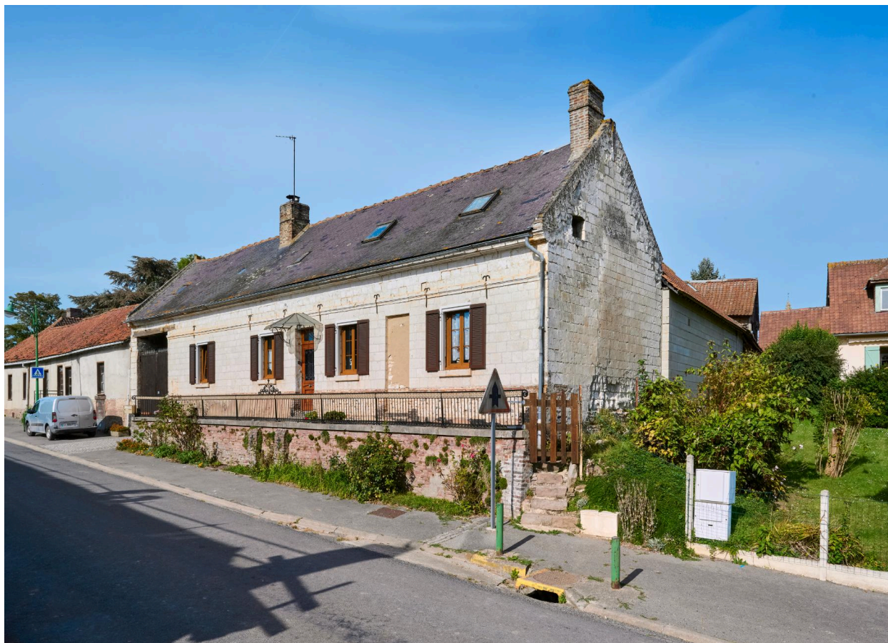
Maison, depuis le sud-est.
