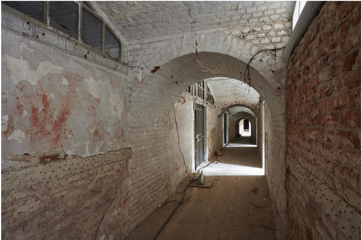
Couloir du sous-sol de caserne de gorge.
