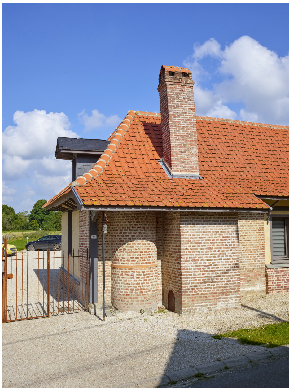
Détail des fours à pain, depuis l'est.
