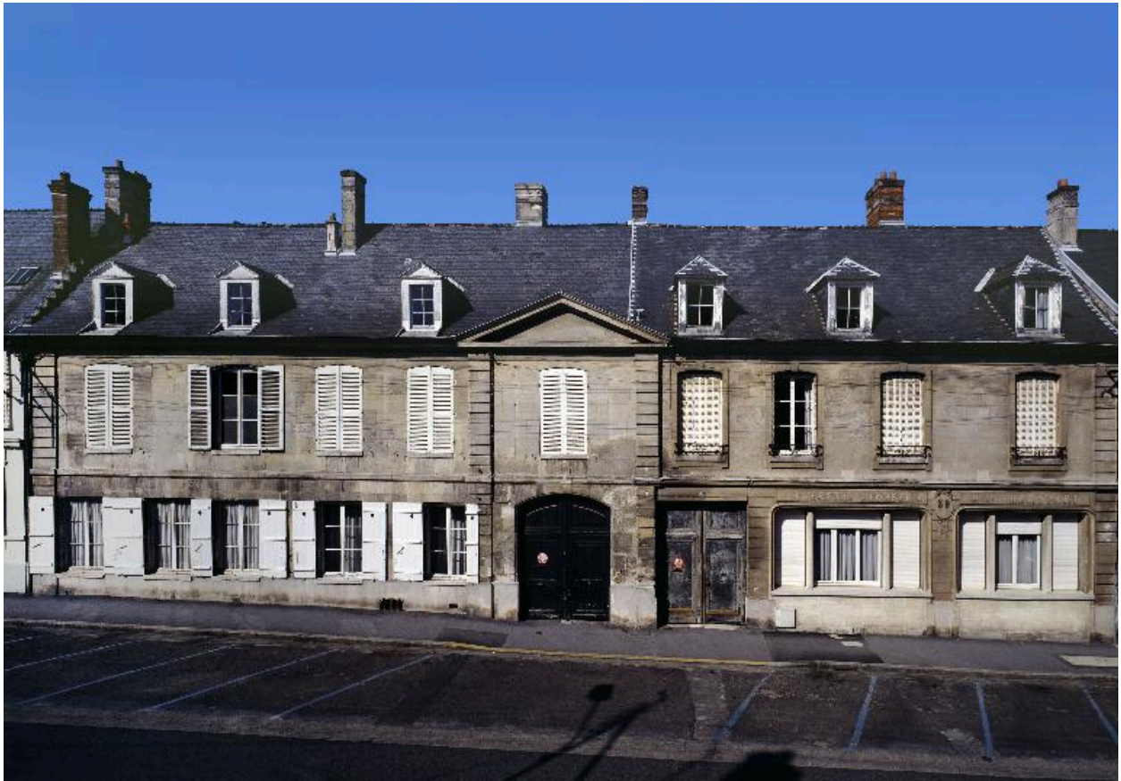
Vue générale de la façade.
