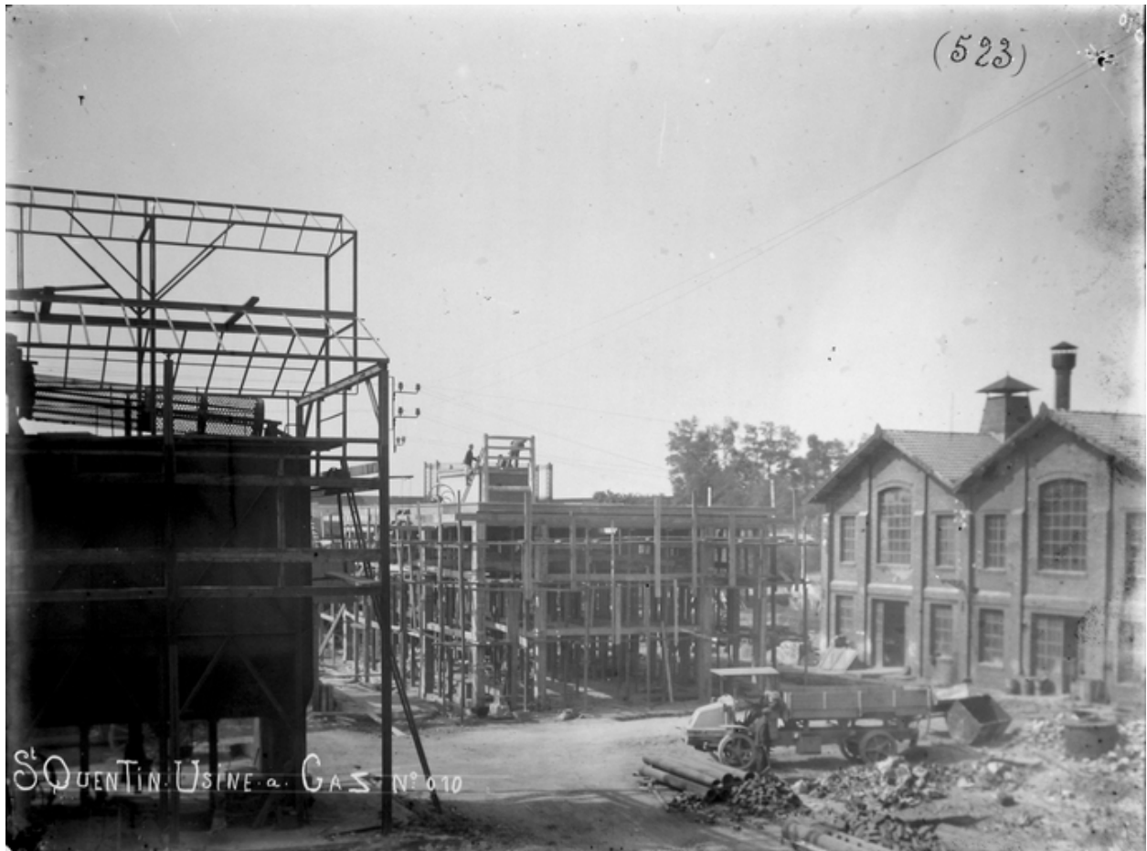
L'usine à gaz en reconstruction, en 1919 (AD Aisne).
