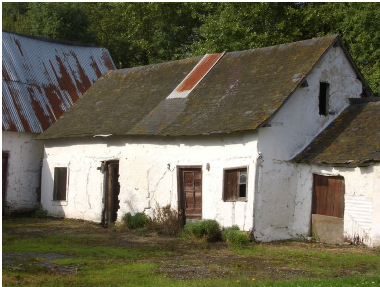
Vue détaillée du logis.
