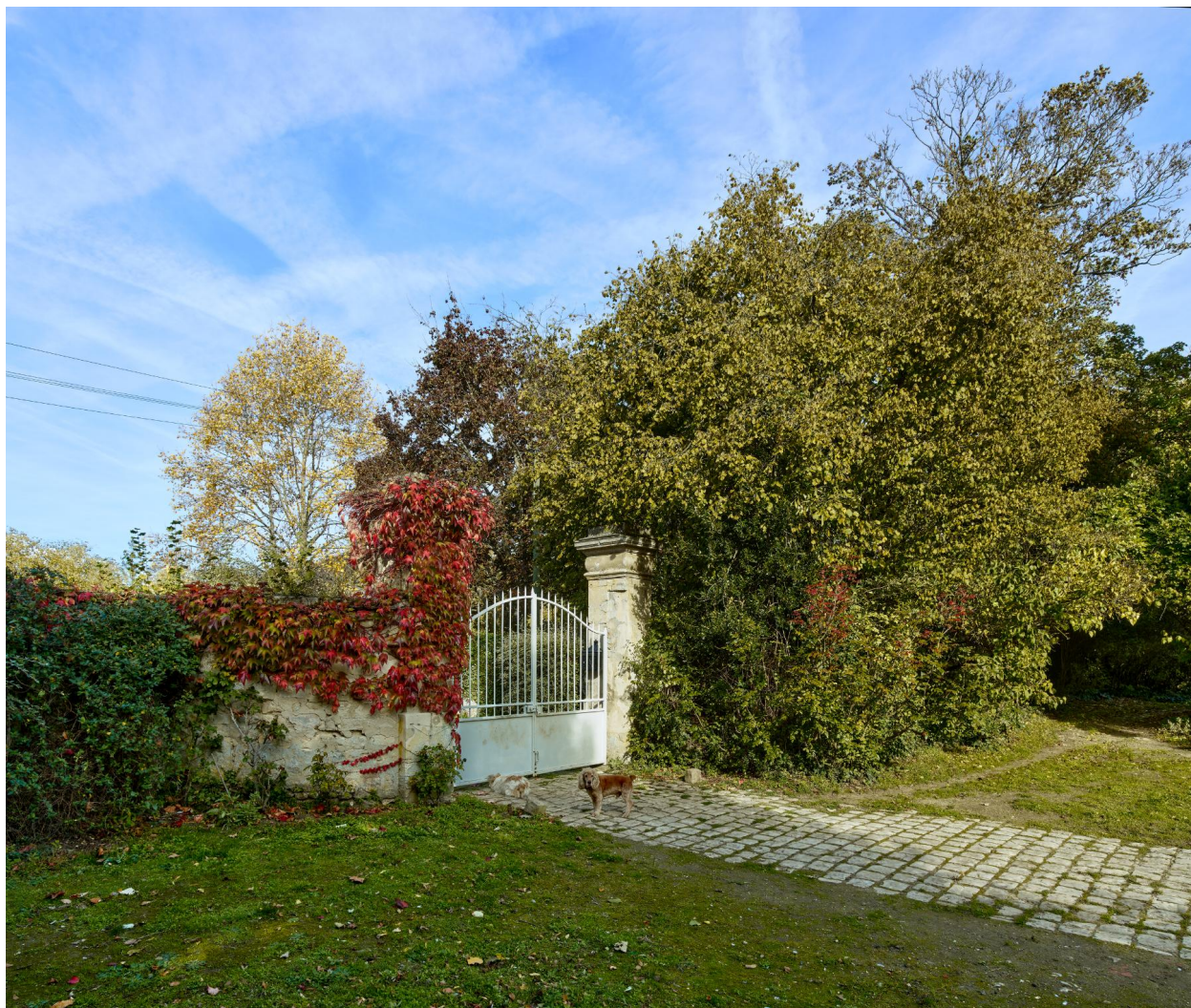
Vue du sud du portail depuis la cour.
