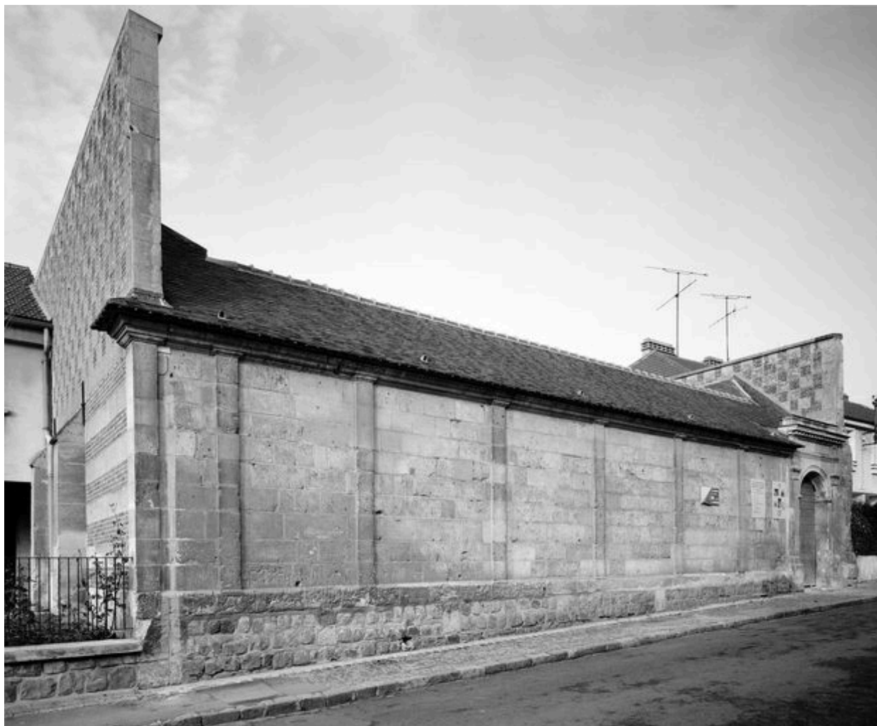
Cloître, élévation sur rue.
