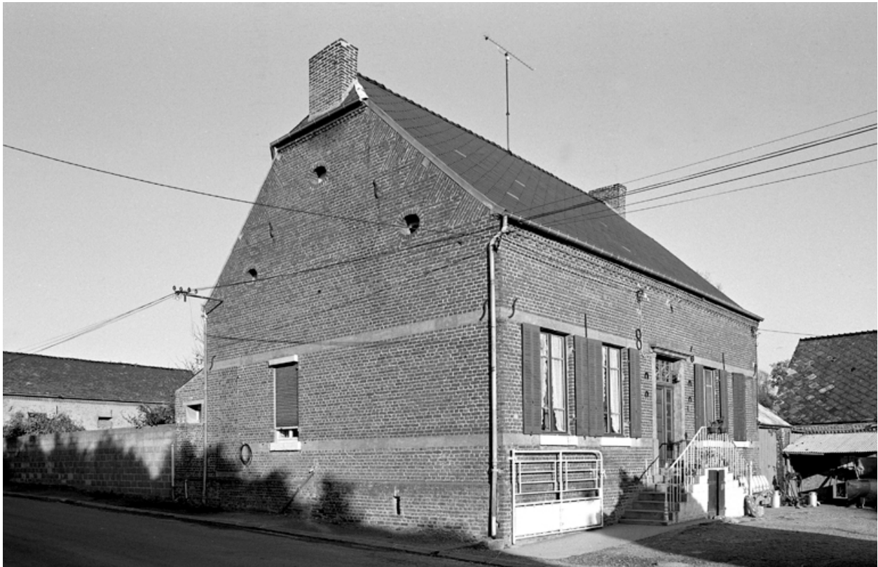
Vue d'ensemble ouest du logis édifié en 1861.
