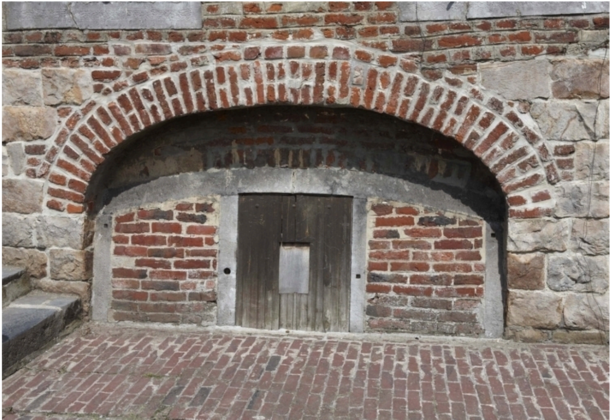
Détail d'une blocure murée (ferme située ruelle du Garde).
