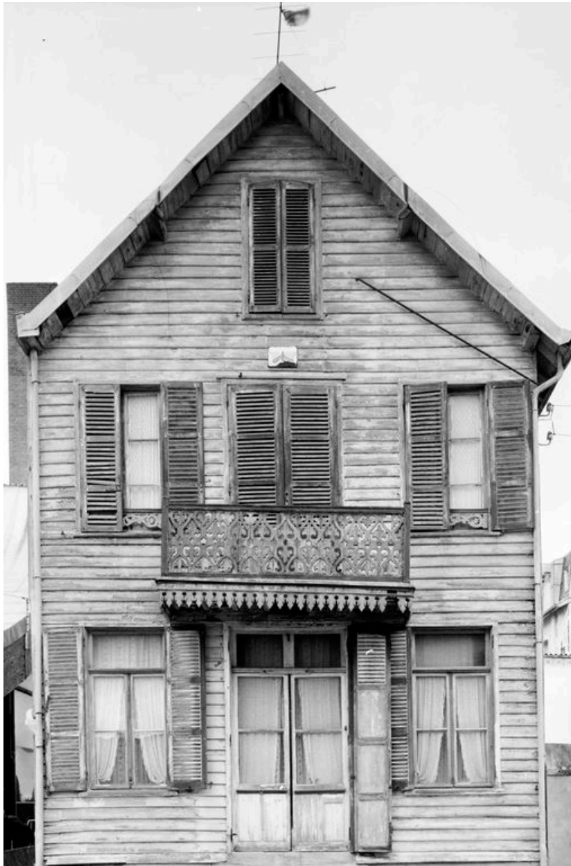
Vue générale de la facade en 1981.
