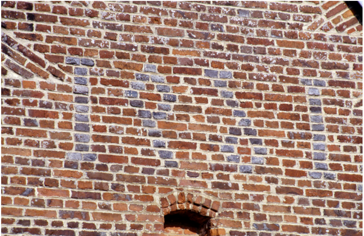
Barzy-en-Thiérache, maison (repérée), 57 Grande-Rue : date 1691 inscrite à l'envers (mur pignon ouest).
