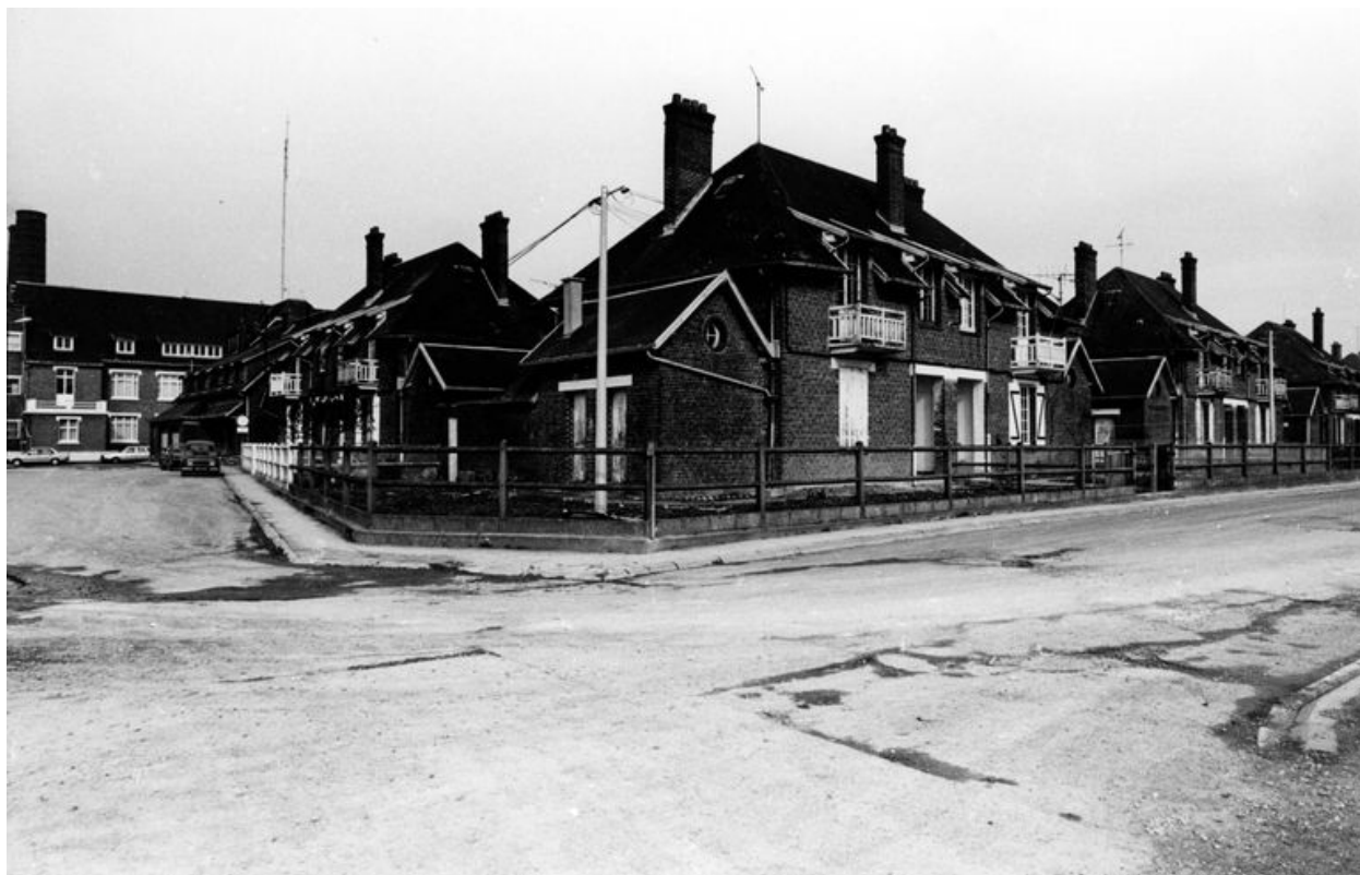
Logements d'ouvriers, en 1983 (Ecomusée du Beauvaisis).
