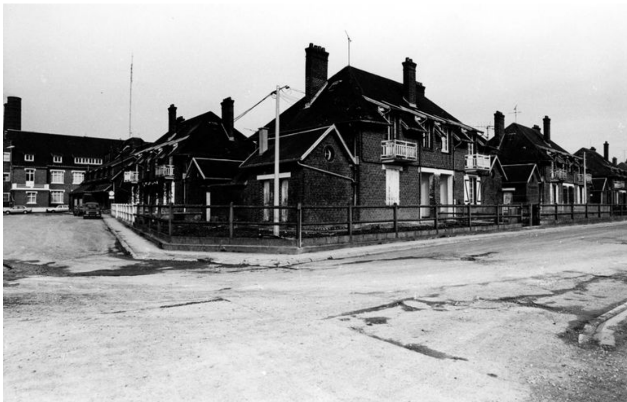
Logements d'ouvriers, en 1983 (Ecomusée du Beauvaisis).
