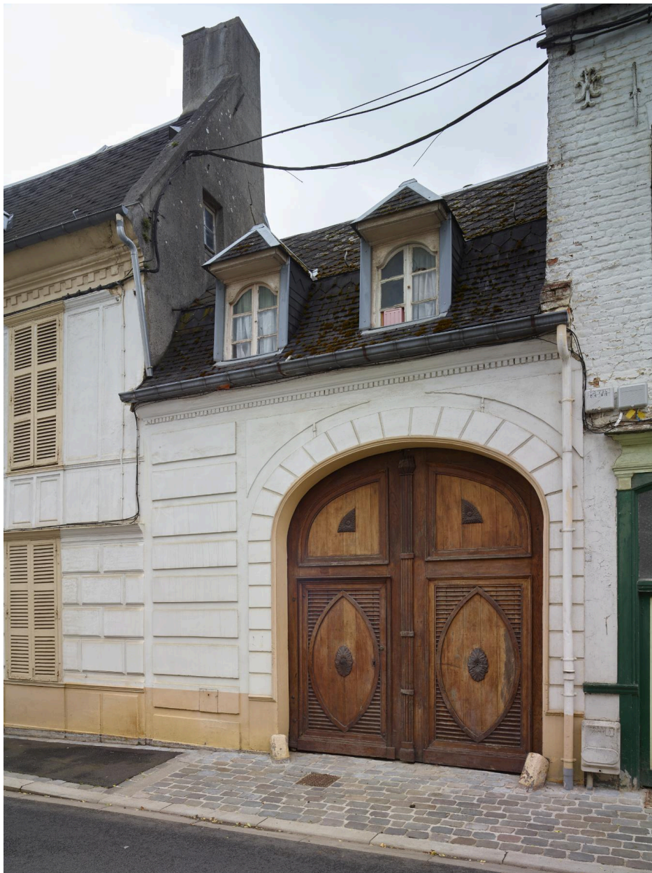
Maison de maître avec porte cochère et balcon (disparu en 2020) - 7, rue Nouvelle-Zélande : détail de la porte cochère.
