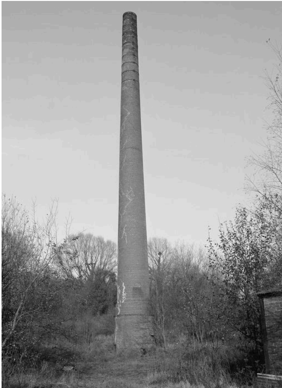
La cheminée d'usine.
