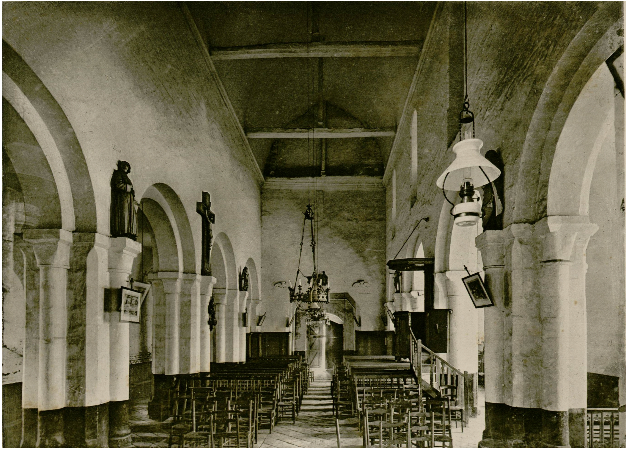
Église de Mareuil, nef de l'église, photographie. In : "Picardie historique et monumentale", vers 1904-1906 (Archives et Bibliothèque patrimoniale d'Abbeville ; Ab.M54).
